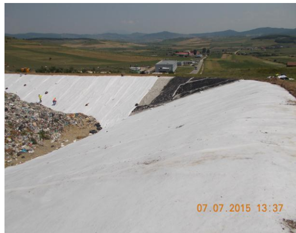
Montare geotextil
