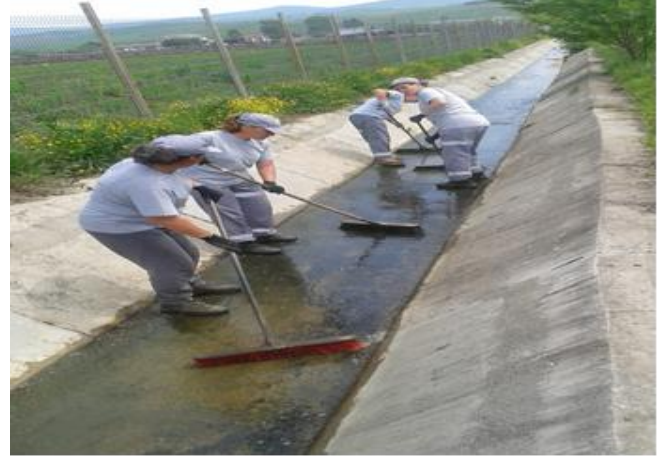
Curățare canal garda
