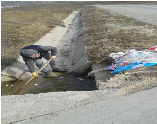
Curațarea camerei de liniștire
