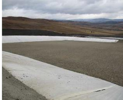
Celula 1 de depozitare - impermeabilizare
