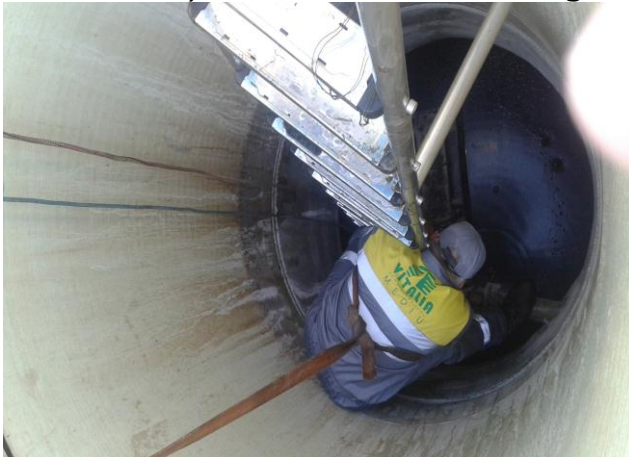
Curățare rezervoare levigat
