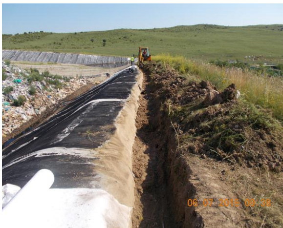
Geotextil deteriorat – partea de Nord și Est
