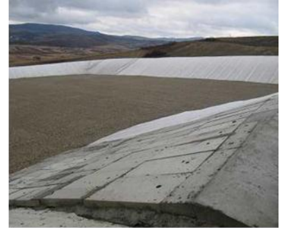
Celula 1 de depozitare - impermeabilizare
