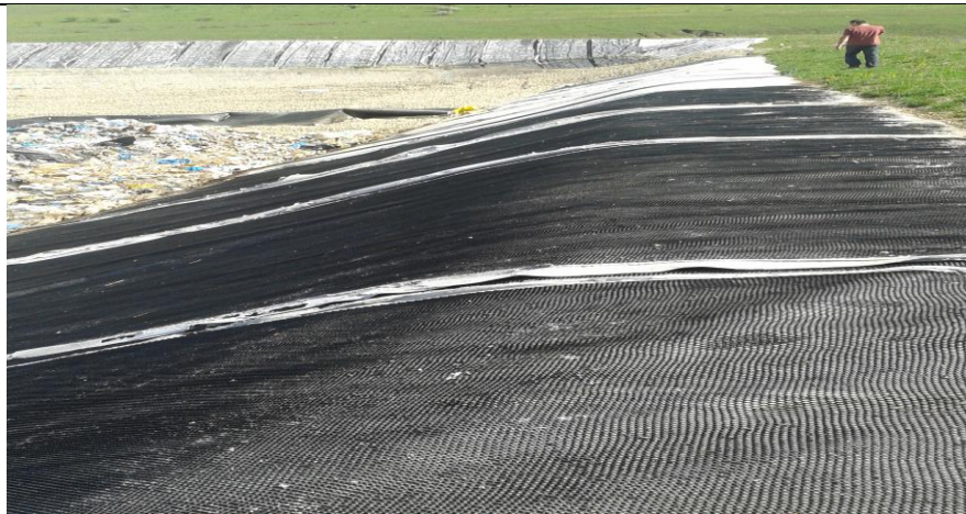
Geotextil deteriorat – partea de Nord și Est
