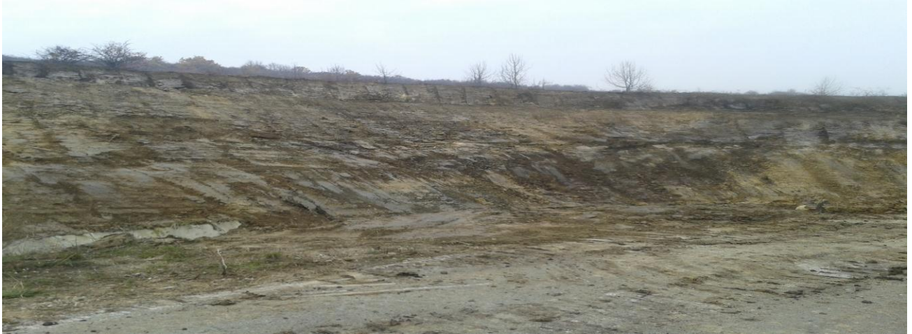
Remediere alunecare colț NV
